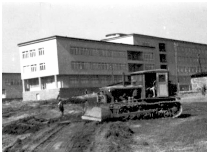
Terénní úpravy stavby nemocnice ■
