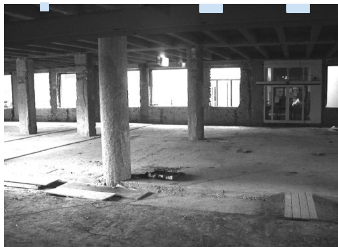
Betonová kostra původních operačních sál ■
